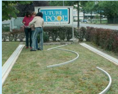
Die Laufschienen sind schon ausgelegt...
